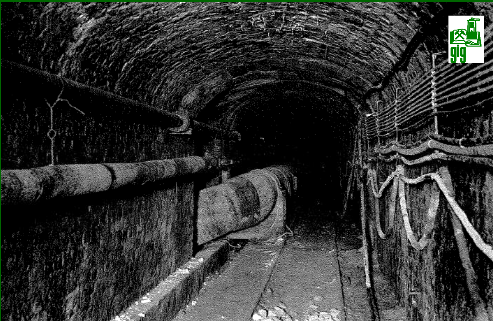
Fragment instalacji pomiarowo-kontrolnej w chodniku 1a, w głębi rurociąg doprowadzający powietrze
