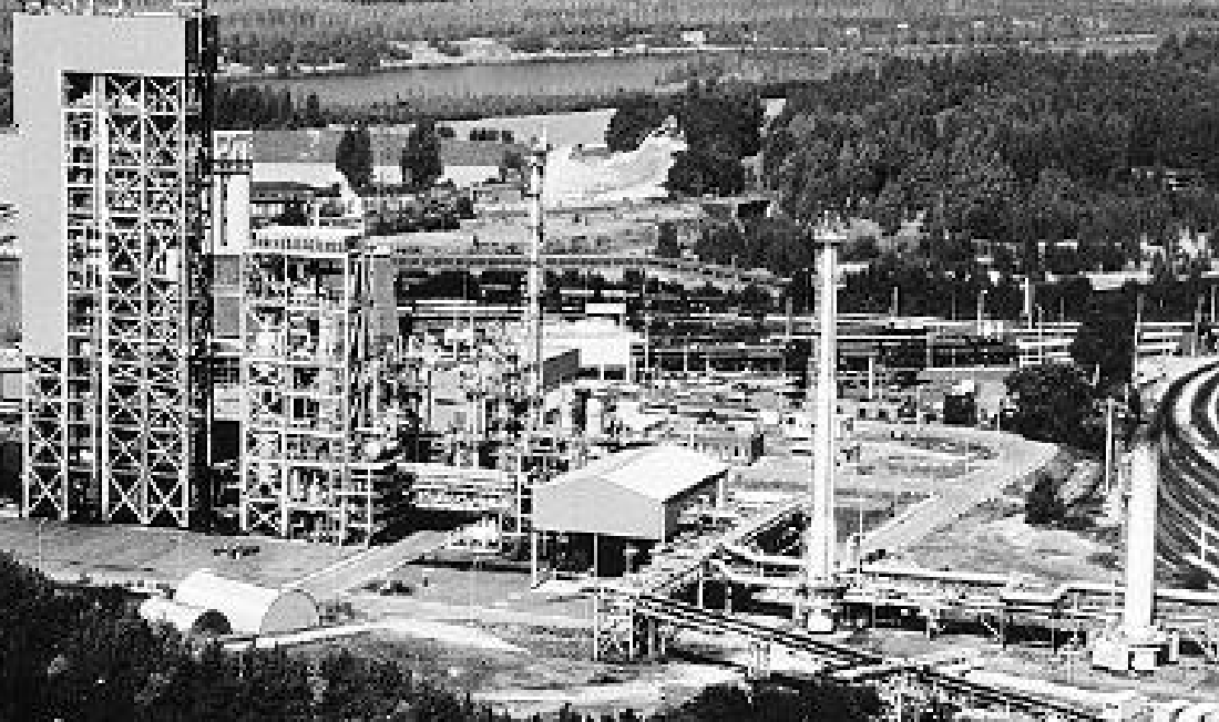
Instalacja demonstracyjna dla technologii HTW Winklera w Berrenath
